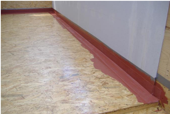
Grundierung und Randabklebung
