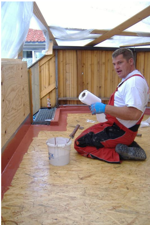
Grundierung und Randabklebung
