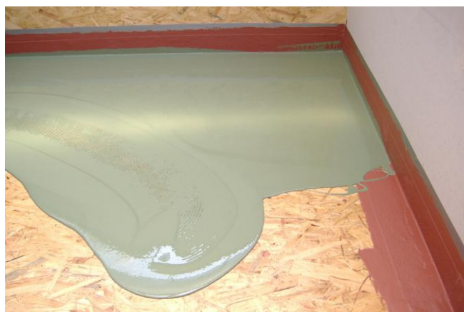
Aufbringen der Dichtungsschicht Rot/Grün
