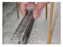
Die Halteleisten sollen vorzugsweise mit Stahlnägeln oder Schlagdübeln befestigt werden. (3 Stahlnägel oder Schlagdübel pro Meter sind notwendig).
