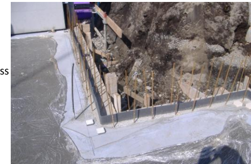
Abdichtung Bodenplatte System „Weiße Wanne“
