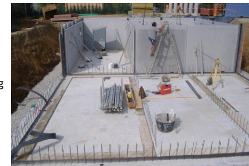
Fertigteil-Wandabdichtung
