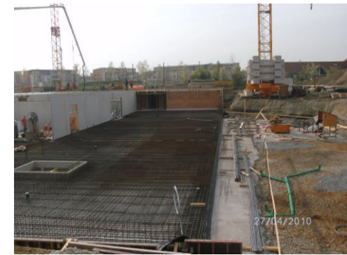
Abdichtung Bodenplatte System „Weiße Wanne“
